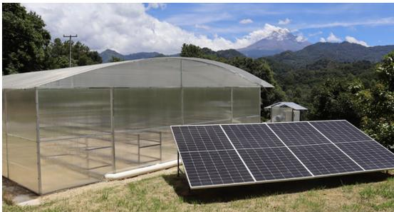
*Fig 4. fotografía de un secador solar tipo invernadero con apoyo de calentamiento de aire por medio de captadores solares. Sistema instalado en el Centro Comunitario para el secado solar de alimentos de Hueyapan, Morelos*
